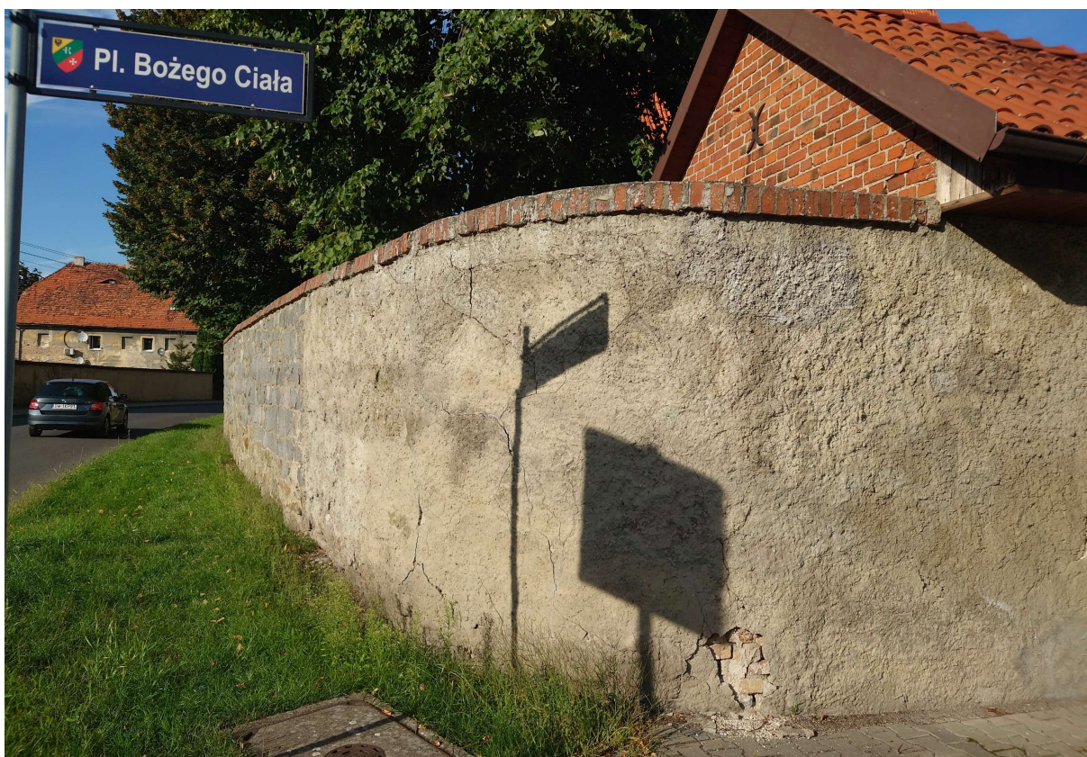
Mur ceglany, otynkowany w części południowo-zachodniej, spękania i uszkodzenia tynku, uszkodzenia rolki ceglanej
