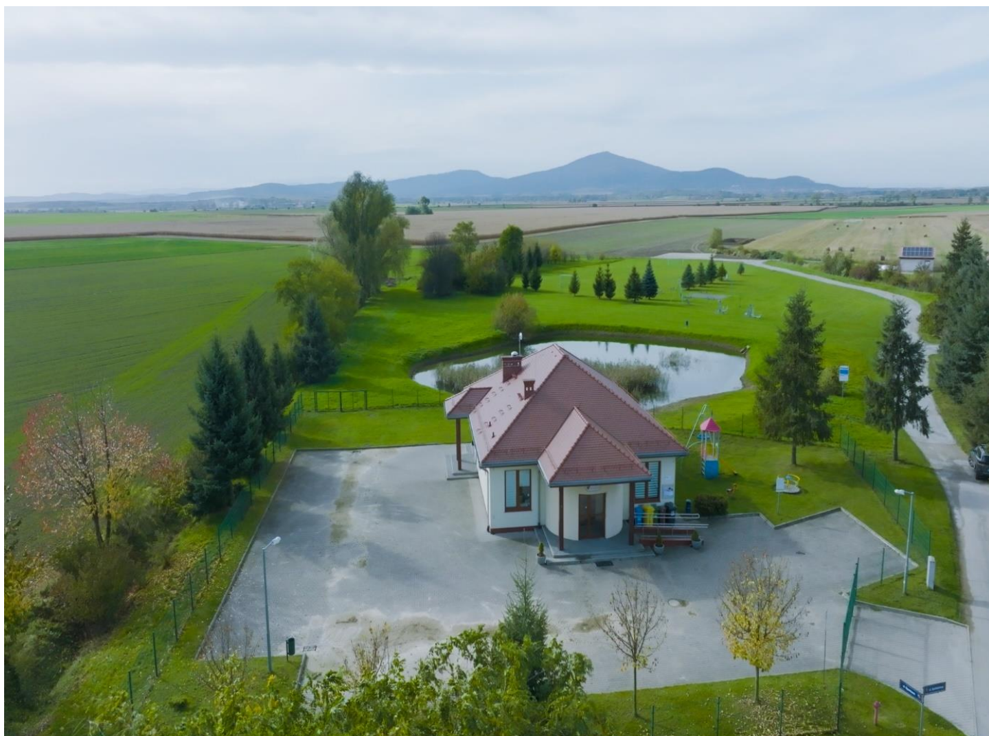
Świetlica wiejska w Damianowicach. Fot. UGK
