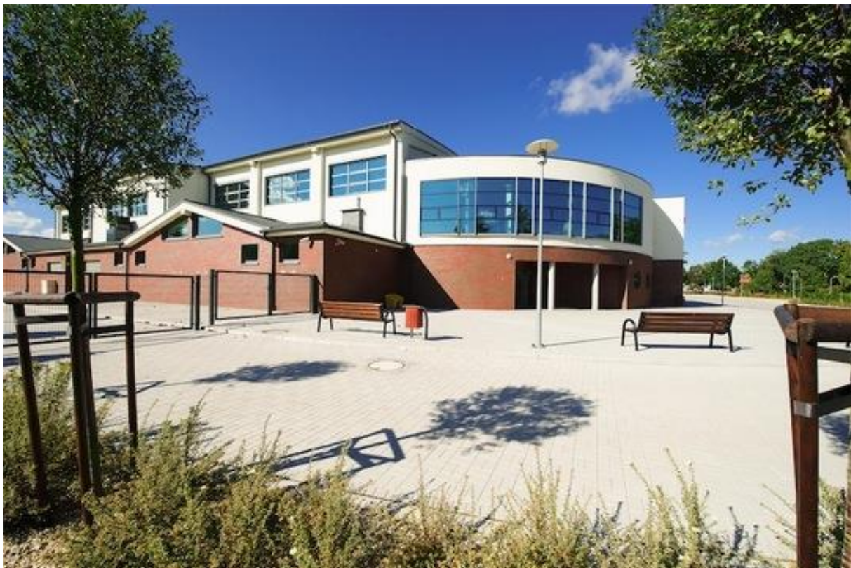
Zdjęcie 4. Hala Widowiskowo - Sportowa w Kobierzycach
