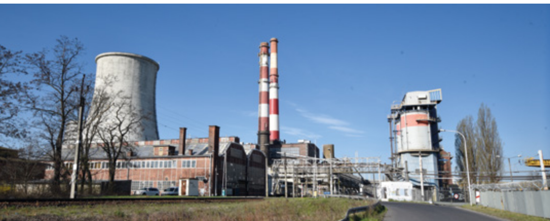
Elektrociepłownia Czechnica w Siechnicach .....
