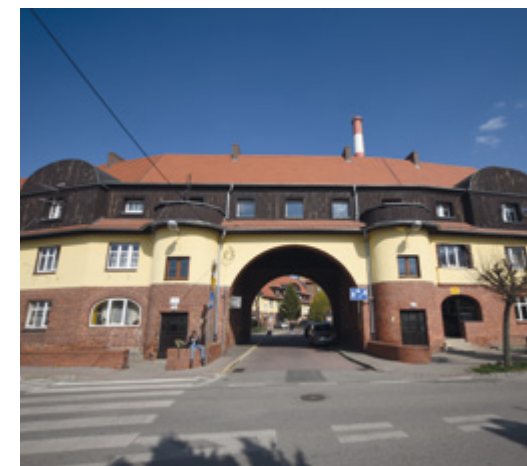
Brama wjazdowa na osiedle mieszkaniowe przy siechnickiej elektrociepłowni
